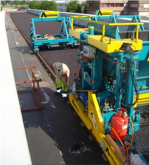
Gussasphalt Brückenbelag in Olten (Schweiz). Einbau mit Überdachung.
