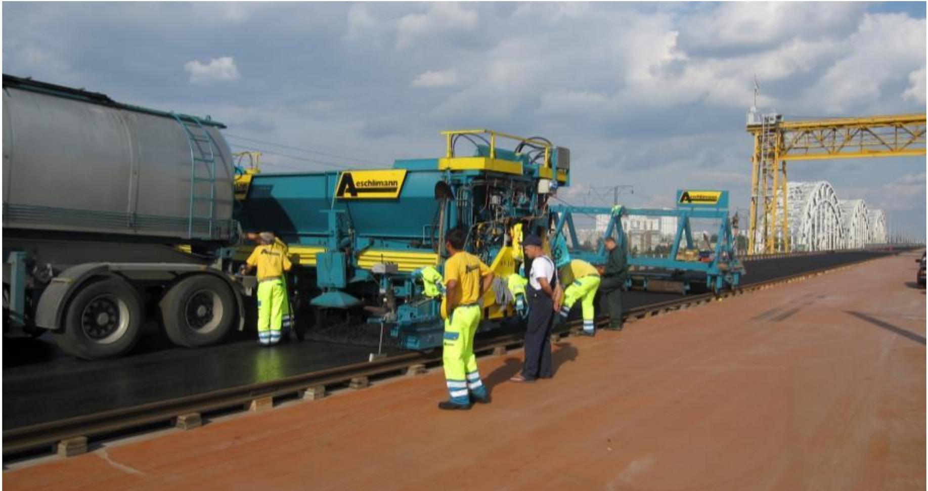
Torun Brücke in Polen, PMMA Abdichtung mit 2 Schichten
