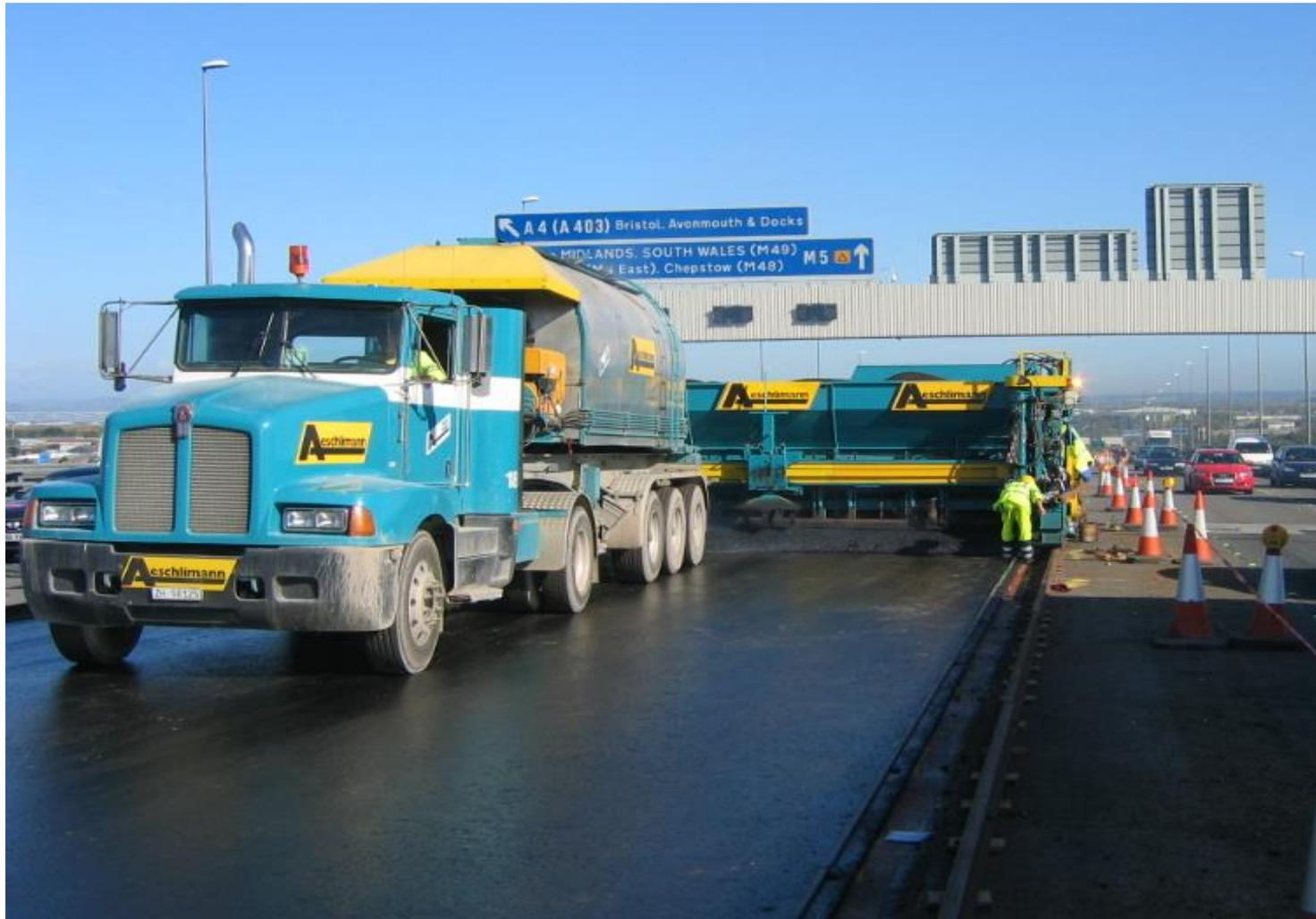
Mit Gussasphalt sind dünnere Belagskonstruktionen auf Brücken möglich.
