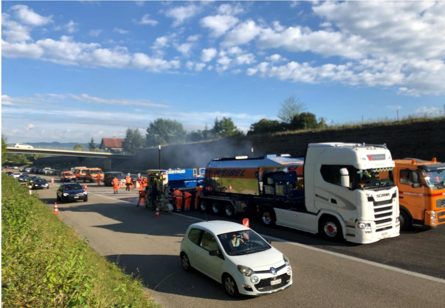
Schneller Gussasphalt-Einbau, 3 Fahrspuren, fugenlos, Autobahn Baden (Schweiz).
