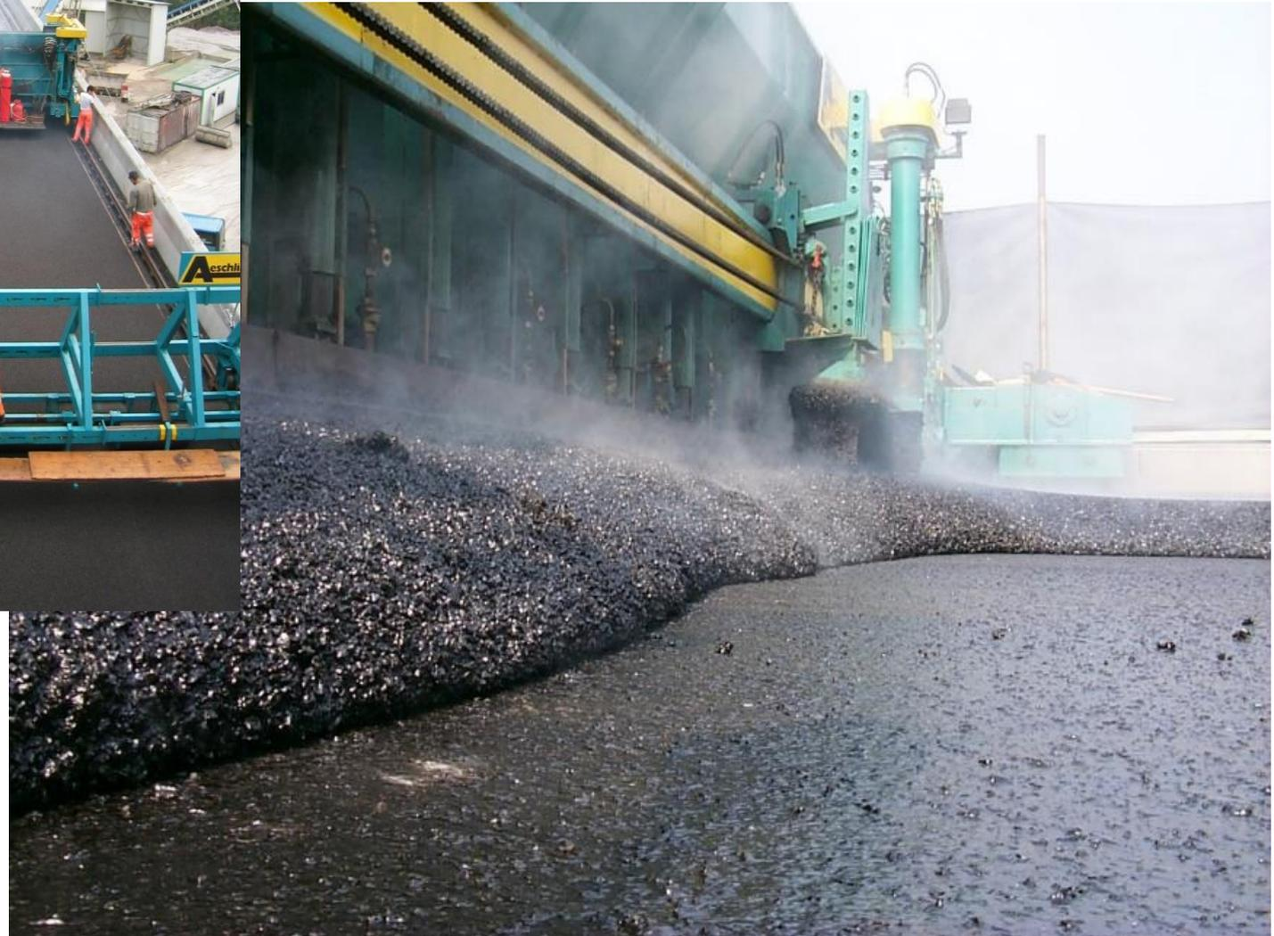
PMMA Abdichtung mit zwei Schichten Gussasphalt
