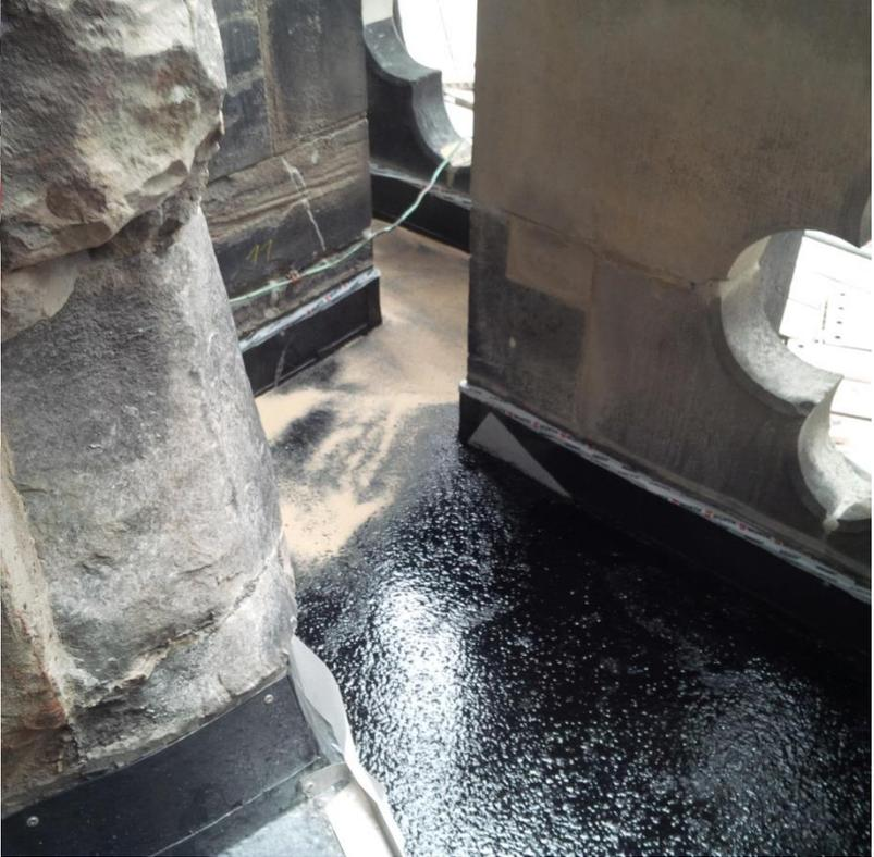
Einbau von Gussasphalt für komplexe Einsatzgebiete. Kirchensanierung mit Gesimsen die innerhalb der Fassade entwässern.
