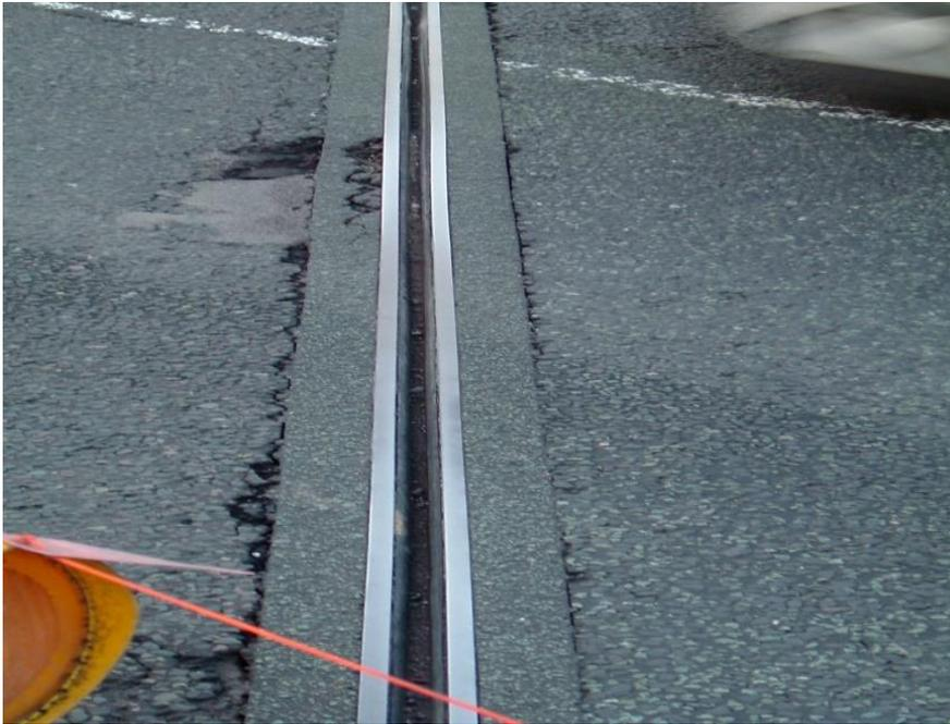
**Die Auswahl von Asphalt und Abdichtung beeinflusst die Leistungsfähigkeit der Fugen.**
