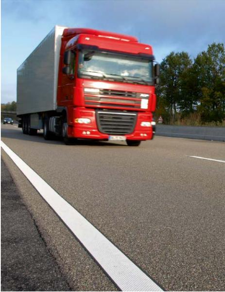
**Bild 2:** Durch das Abstreuen mit künstlichem und/oder natürlichem Aufhellungsgestein lassen sich hellere Asphaltoberflächen herstellen
