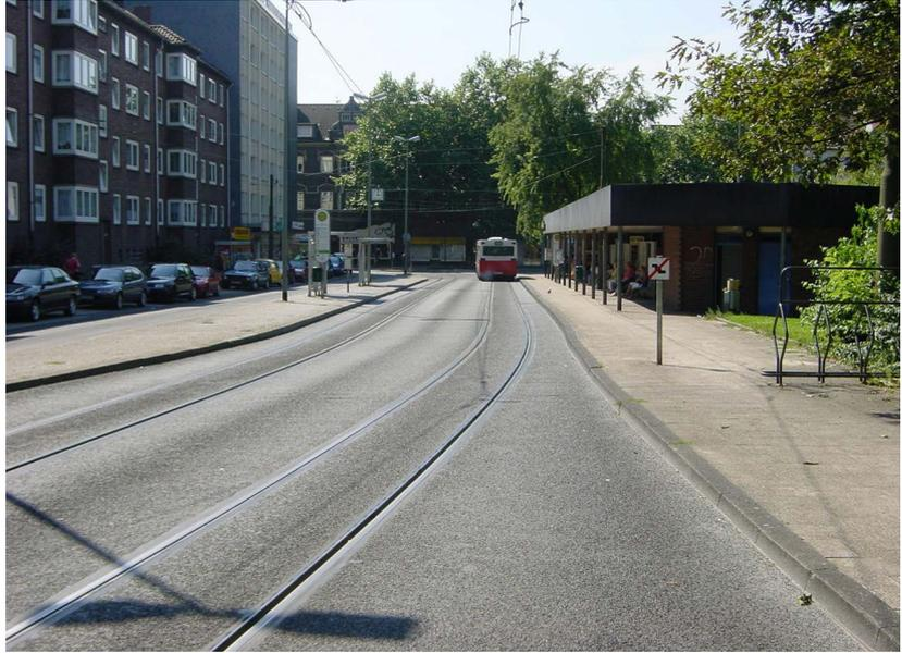
**Bild 3:** Auch auf stark belasteten Busspuren wird Gussasphalt eingesetzt
