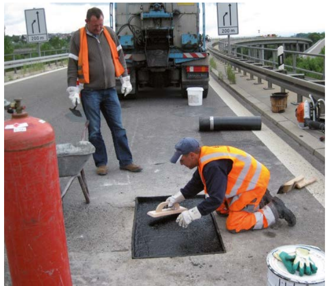
Bild 3: Auch kleine Öffnungen können mit Gussasphalt schnell und dauerhaft verschlossen werden
