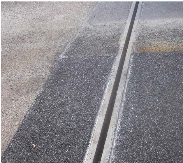
Bild 2: Neu hergestellter Anschluss an eine Übergangskonstruktion
