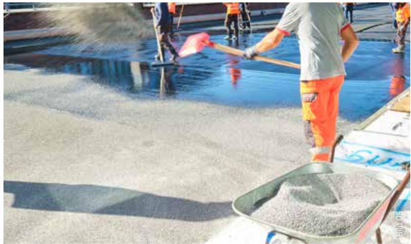
Abstreuen der 2,5 cm dicken Gussasphaltdeckschicht mit Splitt.
