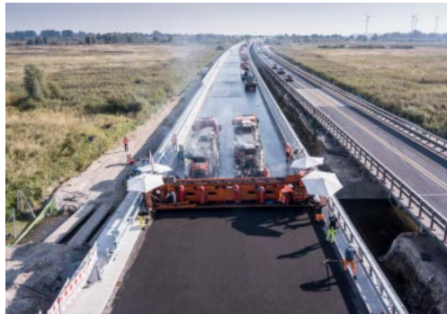
22–29 OSTSEEAUTOBAHN A20 BEI TRIBSEES
