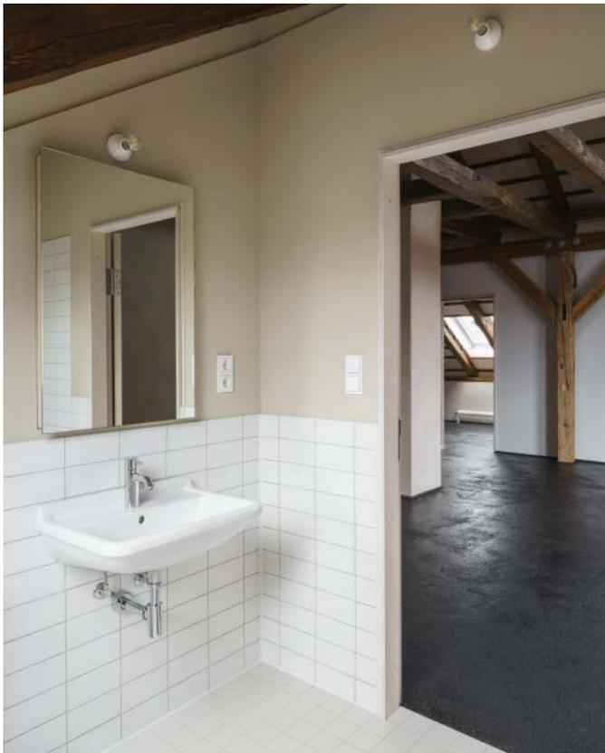
Der Baustoff Gussasphalt kam hier zum einen als Sichtestrich für alle Wohnräume mit Versiegelung sowie als Unterboden für kleinformatige Fliesen in Bädern und Linoleumbahnen in Küchen zum Einsatz. Der Sichtestrich aus Gussasphalt kann – sofern die Mieter dies wünschen – als Unterboden für alle, auch feuchteempfindlichen Beläge dienen. Hierfür wurde bei den Türen eine Demontage von Leisten zur Aufnahme von sich ändernden Aufbauhöhen vorgesehen.
