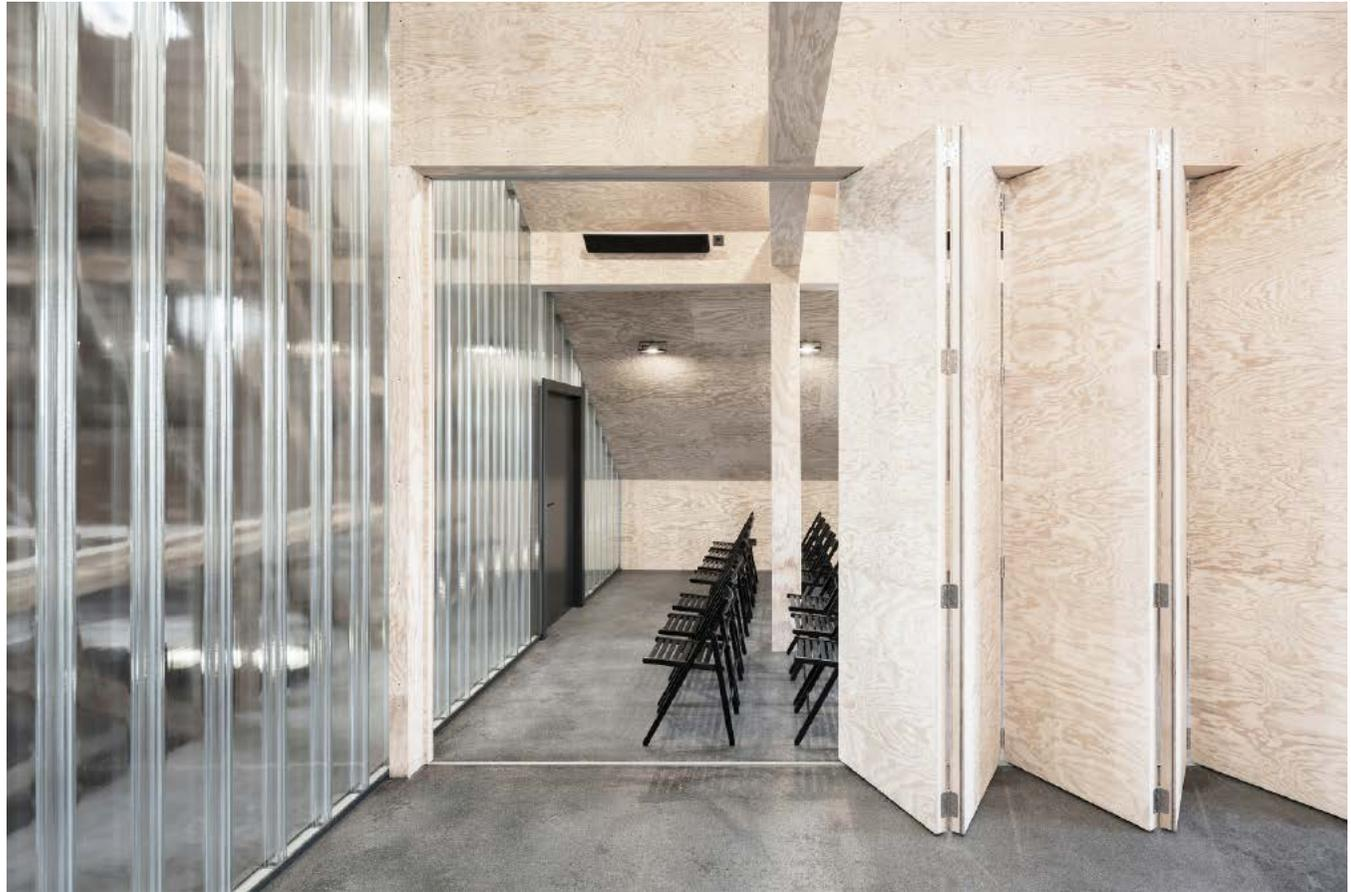
Hier befindet sich der neue Schulungsraum. Um diesen Bereich zu kennzeichnen, sind sämtliche Oberflächen, inklusiv der alten Balken mit Seekiefer-Sperrholzplatten verkleidet. Als Bodenbelag wurde hellgrauer Gussasphalt gewählt. Dadurch entsteht ein neuer, moderner Raum im Kontrast zur historischen Bausubstanz.
