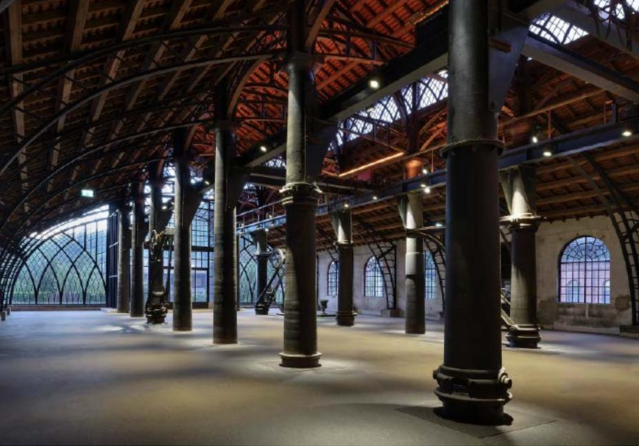
Als geeignetes Material wurde in beiden Hallenbereichen ein geschliffener Gussasphalt-Estrich eingebaut. Die Gießhalle war ursprünglich nur mit einem Sandboden versehen. An diesem angelehnt wurden die Zuschlagstoffe so gewählt, dass hier eine helle assoziierende Farbgebung entstand. Außerdem wurden im Bodenbereich der Außenwände Fußbodenheizsysteme eingebaut, die eine konservatorische Stabilisierung der feuchten Wandbereiche und Fundamente der Gusseisenrahmen ermöglichen.
