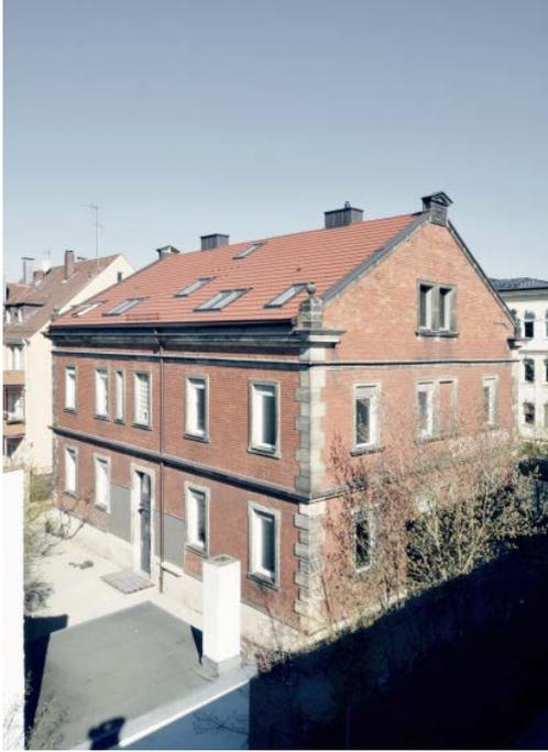
Ziel dieses besonderen Bauvorhabens in Erlangen war, den bestehende Kaldachraum des historischen Mietshauses aus dem Baujahr 1893 mit zwei neuen Wohneinheiten auszubauen. Außerdem sollte in diesem Zuge das Dach energetisch ertüchtigt und die Sichtmauerfassade mit Fensterumfassungen und Gesimsen aus Naturstein saniert werden.
