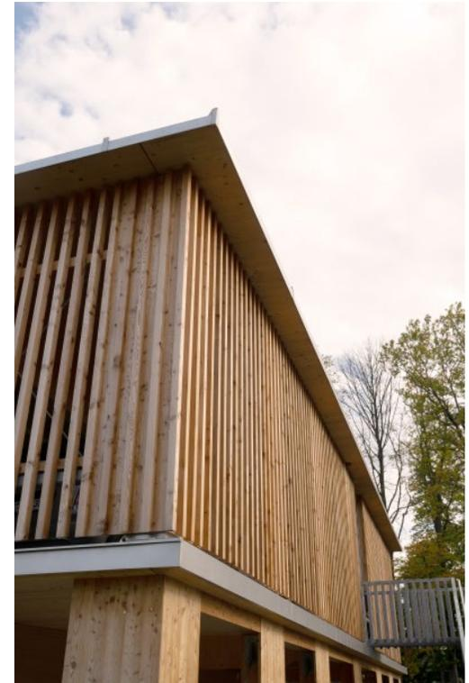
Das Hauptbaumaterial ist Fichtenholz, das in Form von Leimbändern und Brettsperrholz das Tragwerk bildet. Die schlanken Lamellen an der Fassade im oberen Geschoss filtern das Licht und dienen zugleich als Absturzsicherung. Eine elegante gestalterische Lösung, die das Bauwerk durchlässig macht und seinen leichten, modellbauartigen Charakter unterstreicht.
