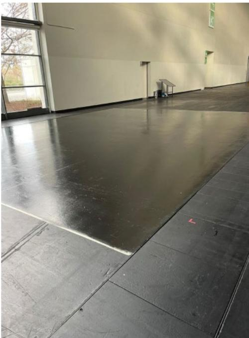
Aus diesem Grund wird seit jeher in allen Hallen direkt genutzter Gussasphalt eingebaut, welcher regelmäßig mit schwarzer Polymerdispersion behandelt wird. In den Osthallen liegen teilweise noch alte Gussasphaltplatten, die ebenfalls von Zeit zu Zeit versiegelt werden.
