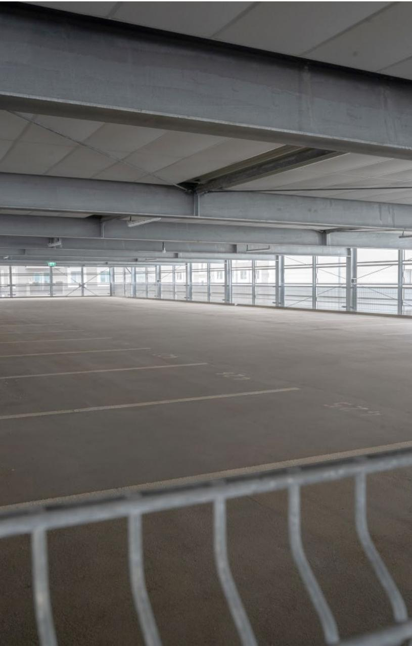
Die Gesamtfläche des Parkhauses beträgt rund 10 500 Quadratmeter. Die Parkflächen sind konstruktiv mit Spannbetonhohldielen hergestellt. Dies bot die Möglichkeit, bis zu 16 Meter stützenfrei zu spannen und somit für optimale Parkfreiheit zu sorgen.
