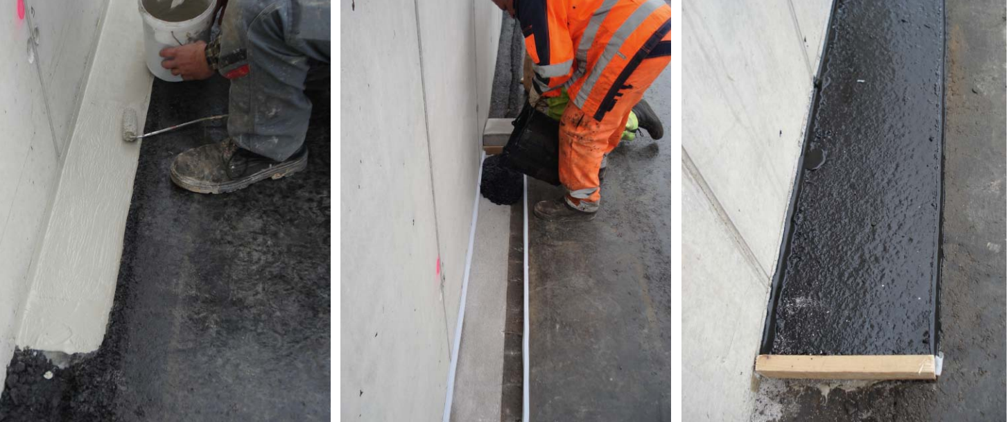
Einbringen der vliesarmierten Flüssigkunststoff-Folie und Herstellen des Gussasphaltstreifens
