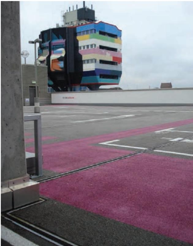
häufig erforderliche Konstruktion stellt die Bewegungsfugenausbildung in Verbindung mit einer Entwässerungsrinne dar, speziell auf geneigten Flächen. Ein weiterer zu lösender Übergang ist der Bereich der gedämmten Parkflächen zu beispielsweise ungedämmten Zufahrtsrampen.
