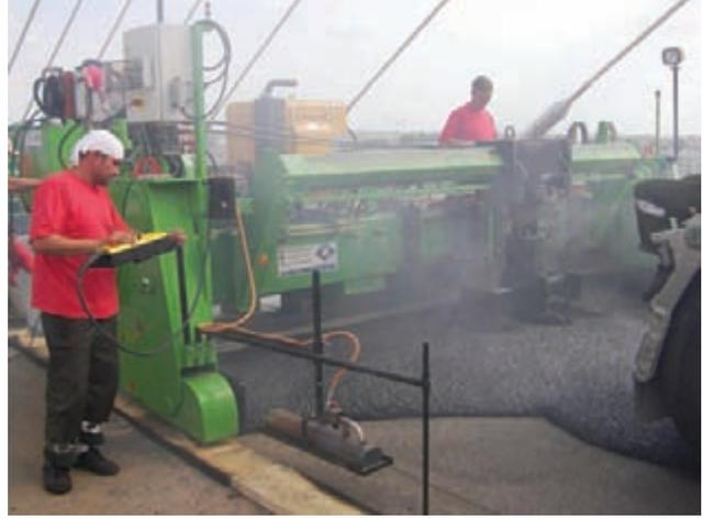
Im Straßenbau erfolgt der Einbau des Gussasphalts nach der Vorbereitung des Untergrundes mittels Gussasphaltpfeger (Einbaubohe). Dieses Großgerät erhöht die Einbauleistung auf Straßen und Brücken um ein Vielfaches. Der Handeinbau beschränkt sich auf kleinteilige Flächen, die besondere Sorgfalt erfordern, z. B. Anarbeiten an Schienen bzw. Arbeiten im Gleisbett.
