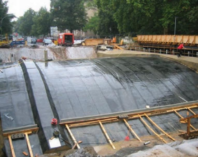
Fingerspitzengefühl gefragt. Zum einen bedurfte es einer Gussasphalt-Mischung aus Bitumen 30/45 und speziellen Bindemittelzusätzen für den Einbau auf geneigten Flächen. Zum anderen schloss das starke Gefälle den Einsatz von Maschinen aus. Daher musste der Gussasphalt aufwändig per Hand aufgetragen werden.
