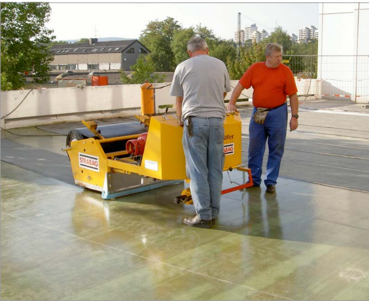
Einsatz der Schweißbahnverlegemaschine
