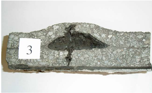
Blasenverlauf im Gussasphalt
