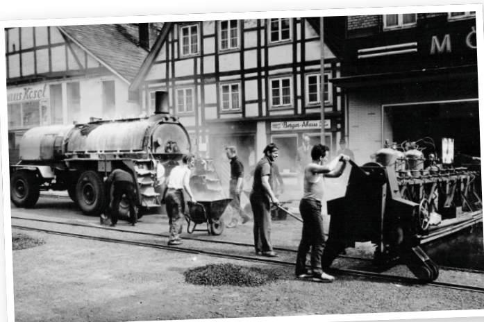
Gussasphalteinbau in den 1950er Jahren
