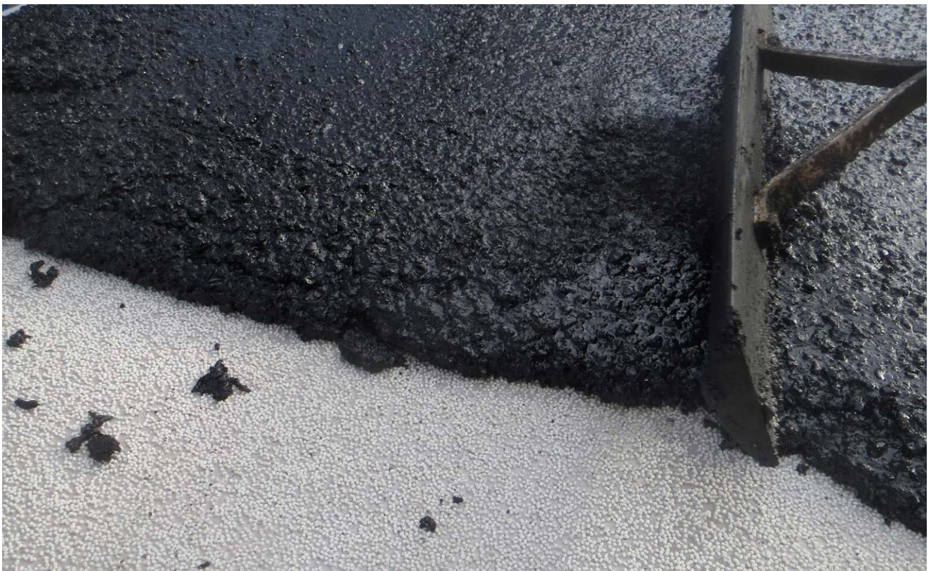
Der Gussasphalt wird als Schutzschicht auf das Abdichtungssystem eingebaut.
