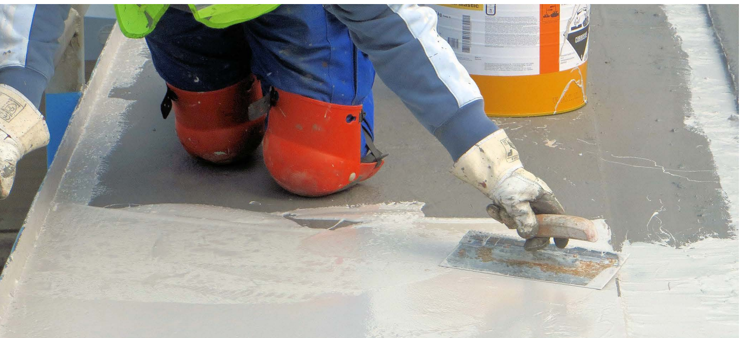
Verarbeitung der Reaktionsharzhaftschrift SikaCor HM Mastic
