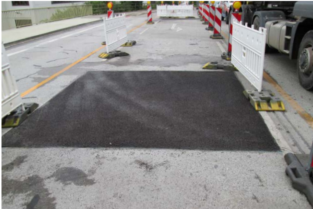
Gussasphalt im Bereich einer Spannglieduntersuchung auf einem Brückenbauwerk
