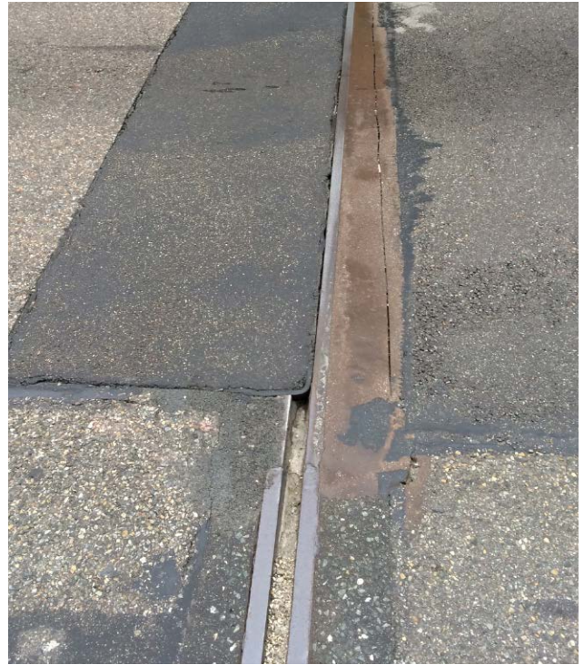
Oben: Belagsausbruch an einer Übergangskonstruktion und fertig bearbeitetes Provisorium
