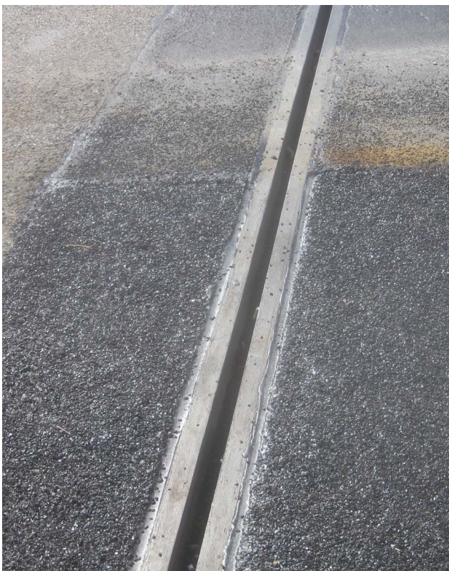
Gussasphalt als Deckbelag im Bereich einer partiell erneuerten Übergangskonstruktion
