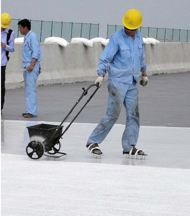
Einstreuung des Schmelzklebergranulats mit dem Einstreuwagen
