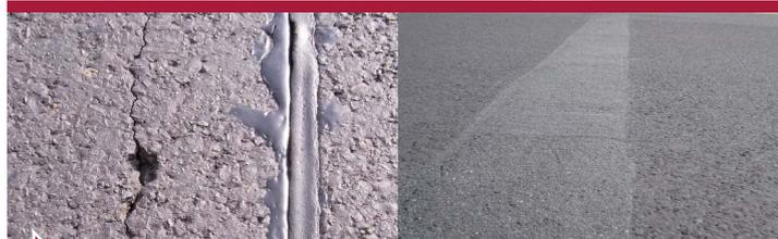
**Fugensanierung, speziell auch für Flugbetriebsflächen (REP-AIR JOINT)**
