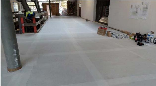
Fläche mit Glasvlieskaschierung, als temperaturbeständige Verzugschicht unter der Verlegeplatte der Fußbodenheizung
