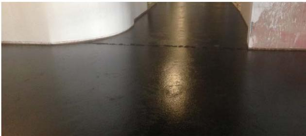
Auf Ausgleichsschüttung aus expandierter Perlite werden, zum Höhenausgleich teilweise dreifach versetzt übereinander, die Dämmplatten stumpf gestoßen, im Verbund verlegt. Sie bieten damit eine zuverlässige, nichtbrennbare, trittfeste Unterlage für den Gussasphaltestrich. In diesem Fall sogar in Form eines Heizestrichs, wobei die Heizrohre durch die Verlegefolie hindurch direkt im Dämmstoff verankert werden.
