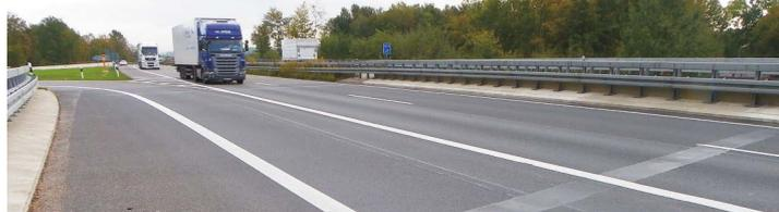
**Fahrbahnübergänge aus Asphalt (THORMA JOINT) und Polyurethan (Polyflex Advanced PU)**
