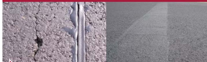
▶ **Fugensanierung, speziell auch für Flugbetriebsflächen (REP-AIR JOINT)**
