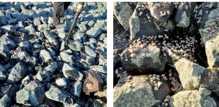
Bereich wechselnder Wasserstände mittels Asphalteingussmasse vorgesehen. Der anschließende 300 Meter lange, neu angelegte Deichabschnitt sollte dann in voller Breite mit Asphaltmastix verklammert werden.
