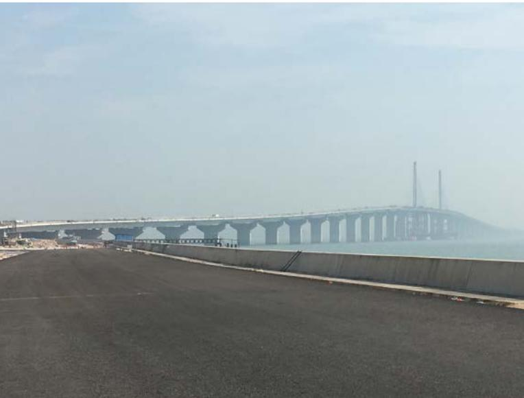
Die Gesamtlänge dieses Bauwerks beträgt 36 Kilometer, davon entfallen etwa 30 Kilometer auf die Brückensektionen und 6 Kilometer auf den Tunnelabschnitt. Mit 3 Fahrbahnen je Richtung und zusätzlichem Seitenstreifen hat die Brücke eine Gesamtbreite von 35 Metern.
