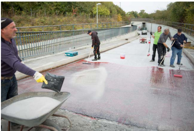
Der gesamte Stahlbeton-Untergrund wurde mit den PMMA-Systemlösungen grundiert und mit Quarzsand abgestreut.
