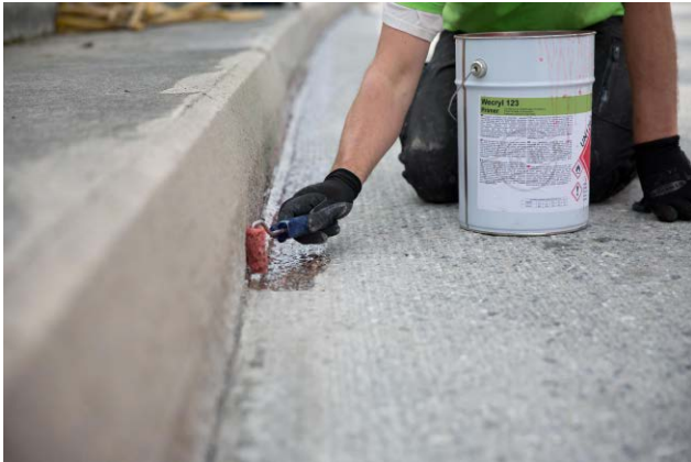
Nach der Untergrund-Vorbereitung wurde die PMMA-Grundierung von WestWood zunächst am Schrammbord aufgebracht.
