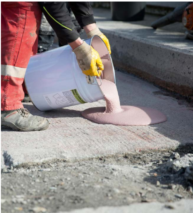
Mit dem vorkonfektionierten Kratzspachtel ließen sich die großen Rautiefen problemlos egalisieren.
