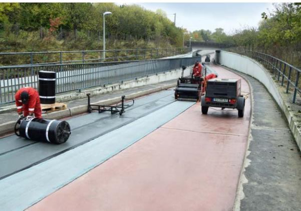
Die Abdichtung erfolgte mit einer gemäß TL/TP-BEL-B Teil 1 geprüften Schweißbahn.
