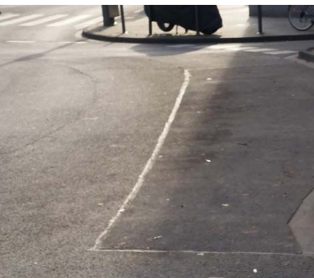
Abbildung 2 Fuge in Gussasphalt nach 1,5 Jahren Liegezeit
