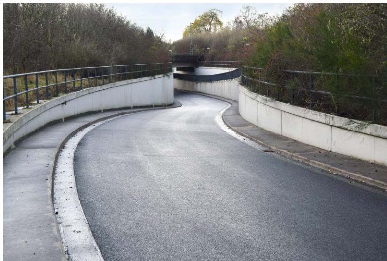
Das sanierte Trogbauwerk ist dauerhaft sicher abgedichtet und hält den Beanspruchungen im Straßenverkehr stand.
