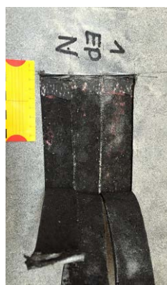
Trennfall a: Trennung in der Bitumenbahn
