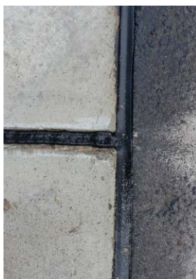
Abbildung 3 Fahrsilo, Wand-Bodenfuge mit TOK®-Sil Resist
