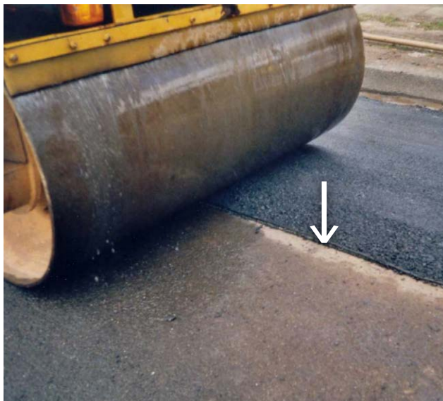
Abbildung 1 Eingebautes Bitumenfugenband
