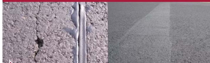
**Fugensanierung, speziell auch für Flugbetriebsflächen (REP-AIR JOINT)**
