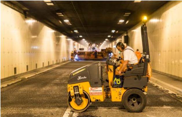
Für den maschinellen Deckschichteneinbau in voller Fahrbahnbreite standen ausschließlich die Nachtstunden von 20.00 Uhr bis 5.00 Uhr zur Verfügung. Nur für diesen Zeitraum wurden vom Bauherrn zusätzlich Sperrmaßnahmen für den Materialtransport durch die angrenzenden Tunnelröhren zugelassen.
