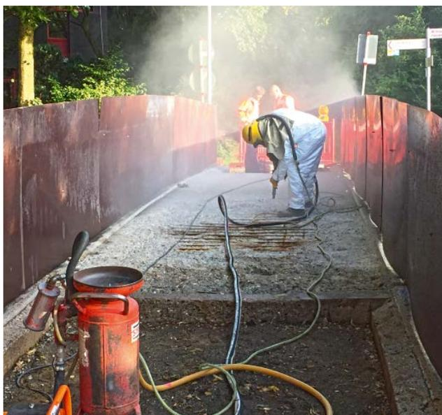
Die Schäden der Betonoberfläche reichten teilweise bis zur Bewehrung.
