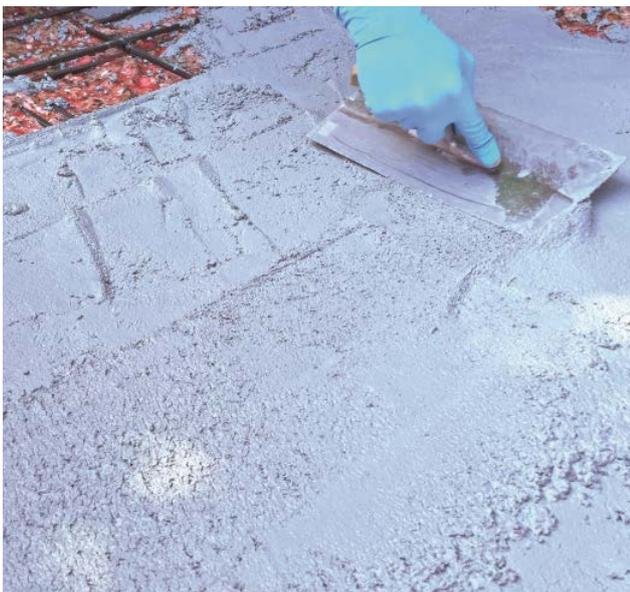
*Nach bereits 20 Minuten konnte der Betoninstandsetzungsmörtel zur Egalisierung eingesetzt werden.*
