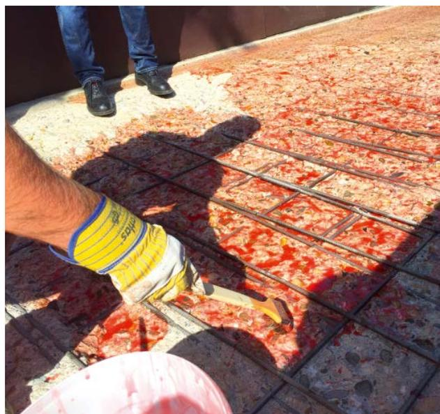
Der Betonuntergrund wurde bis zur Sättigung grundiert.
