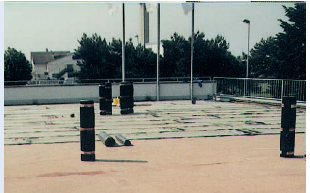
Einbau der Bitumen-Schweißbahnen auf der versiegelten Betonfläche
