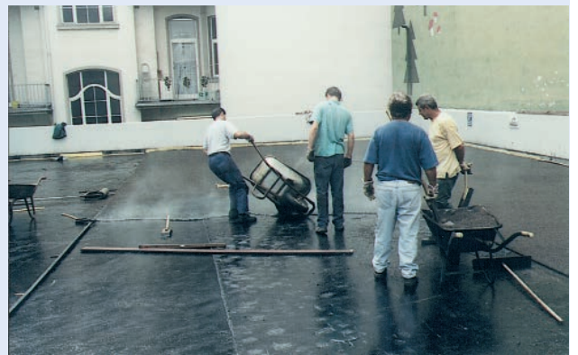
Einbau der Gussasphaltnutzschicht
