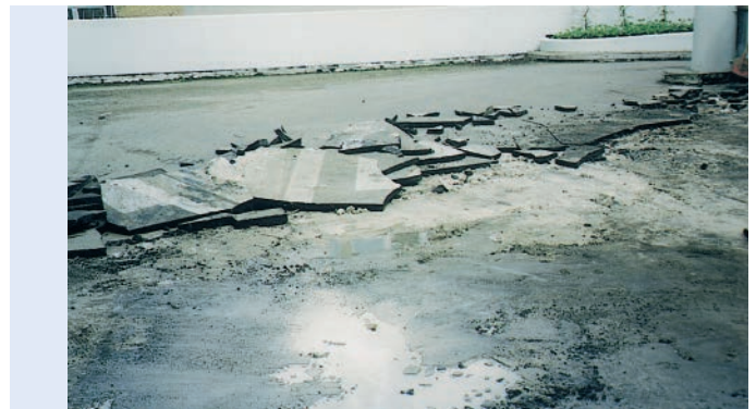
Abriss schadhafter Deckschicht auf Parkdeck
