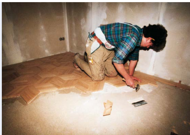
oben: Parkettverlegung auf Gussasphalt unten: Altes Eichen- und neues Bucheparkett auf 50 Jahre altem Gussasphalt
