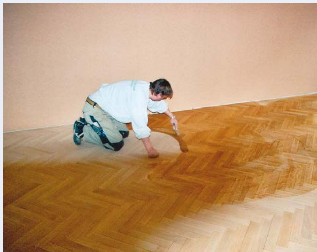
oben: Parkettverlegung auf Gussasphalt unten: Altes Eichen- und neues Bucheparkett auf 50 Jahre altem Gussasphalt
