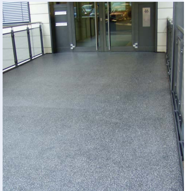
Abgeschliffener Gussasphaltestrich mit Terrazzo-Effekt im Außenbereich (unten) und Beschichtung auf Kunstharzbasis (oben) für direkte Nutzung im Innenbereich
