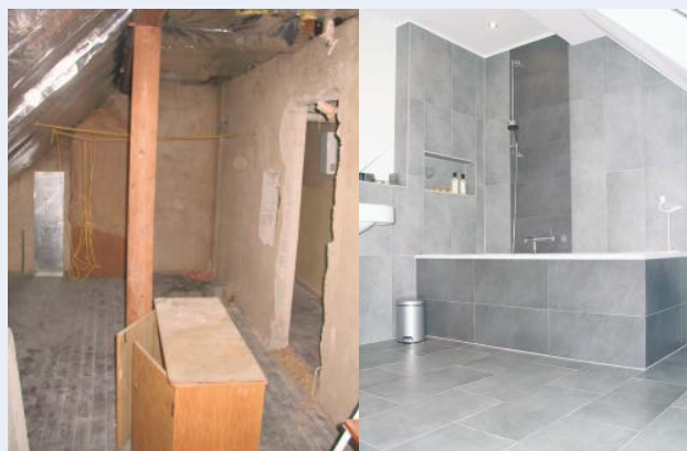
Mit Gussasphaltestrich und elektrischer Heizmatte vom Dachboden mit Holzdielen zum modernen Badezimmer mit fußwarmen Feinsteinzeugfliesen.
