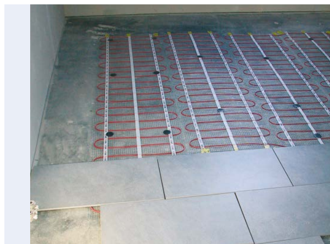
Mit Gussasphaltestrich und elektrischer Heizmatte vom Dachboden mit Holzdielen zum modernen Badezimmer mit fußwarmen Feinsteinzeugfliesen.
