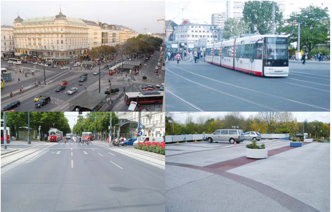
Oben links: Klassische Verkehrsnutzung im kommunalen Bereich am Beispiel des Opernrings in Wien. Auto, Straßenbahn, Bus, Fahrrad und Fußgänger. Oben rechts: Kreuzungsbereich mit Gleiszone in der Stadt Wien. Unten links: Vorteile des Gussasphalts in der Gleiszone: niedrige Geräuschentwicklung und weniger Unterhaltungsaufwand. Unten rechts: Oberflächengestaltung auf einem Parkdeck in Verden.
