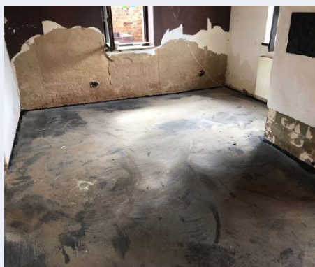
Der neue Gussasphaltestrich wird mit Sand abgerieben
