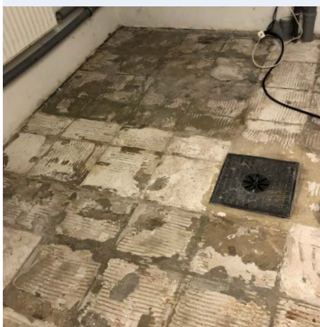
Im Keller muss der gesamte Bodenaufbau bis auf die Bodenplatte entfernt werden
