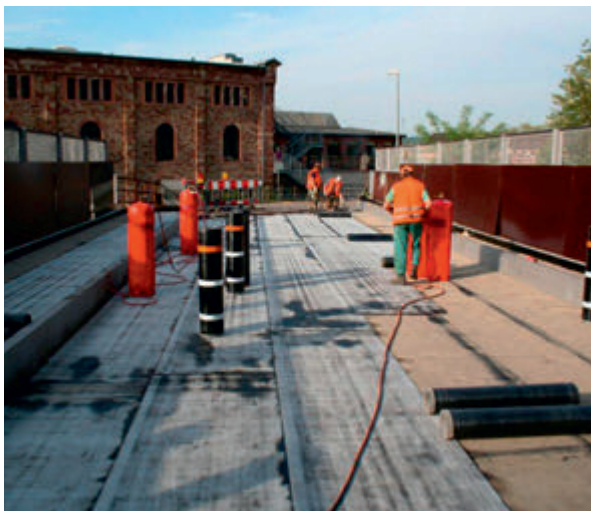
Abb. 12: Aufbringen einer Schweißbahn auf Bitumenbahn V 13
