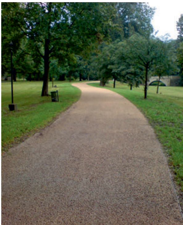
Abb. 5: Parkweg mit hell abgesplitteten Gussasphalt
