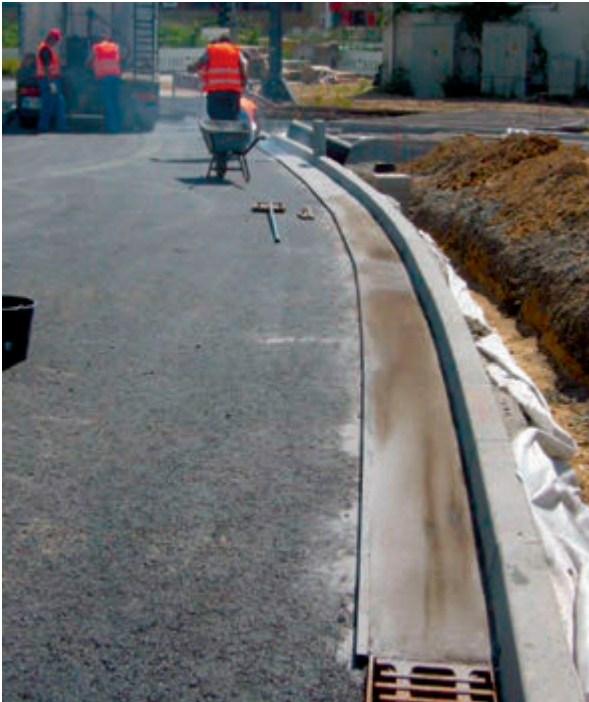
Abb. 8: Randstreifen aus Gussasphalt
