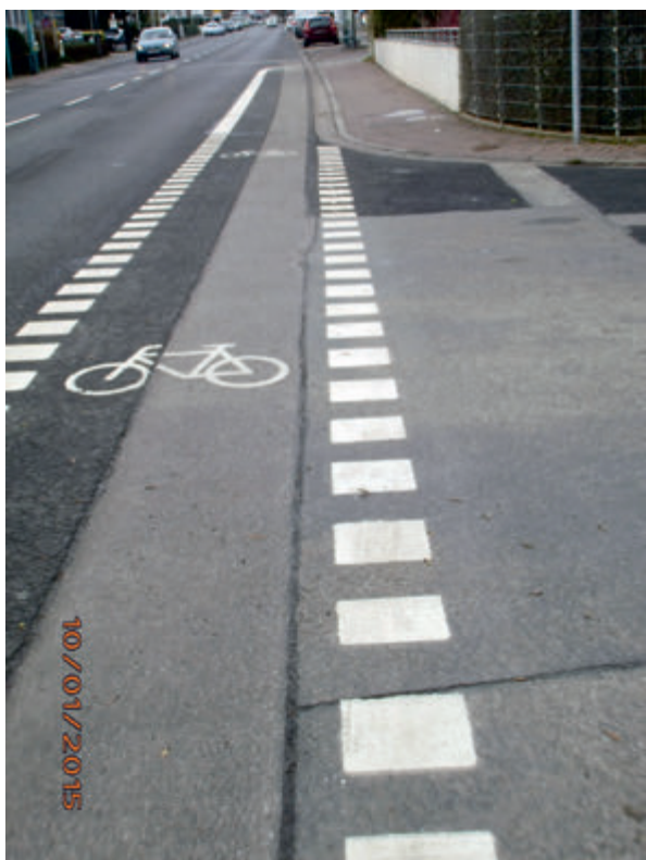
Abb. 13: Deckschichterneuerung mit Gussasphalt nach Aufgrabung für Versorgungsleitungen
