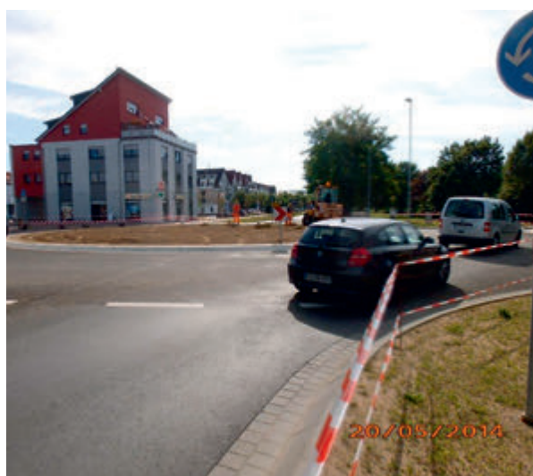
Abb. 4: Kreisverkehr mit Gussasphaltdeckschicht
