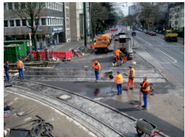
Abb. 1: Einbau Gussasphalt von Hand im Gleisbereich
