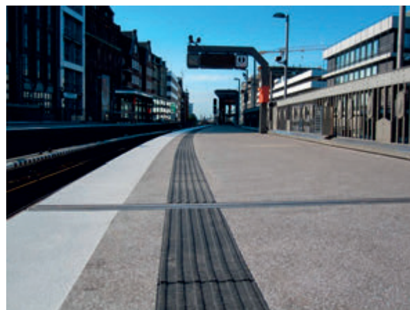
Abb. 3: Gussasphalt im Bahnsteigbereich mit Blindenleitstreifen
