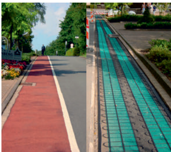
Abb. 7: Fußgängerrampe mit Beheizung im Bau- und fertigem Zustand
