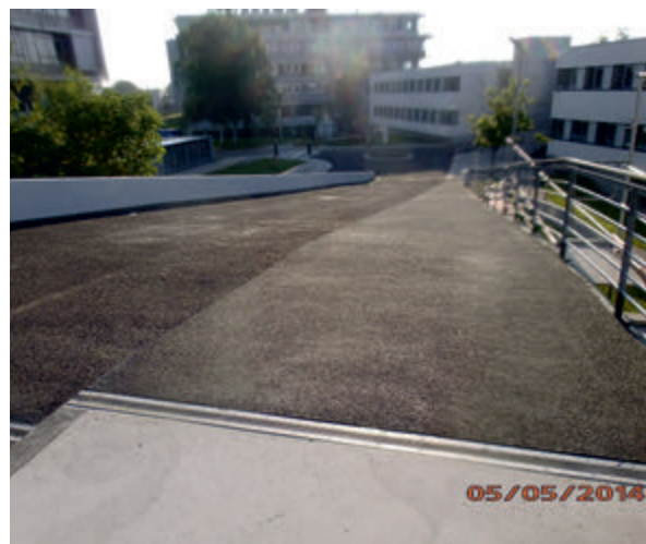
Abb. 6: Parkdeckrampen links mit 2/5 mm, rechts mit 1/3 mm abgesplittet
