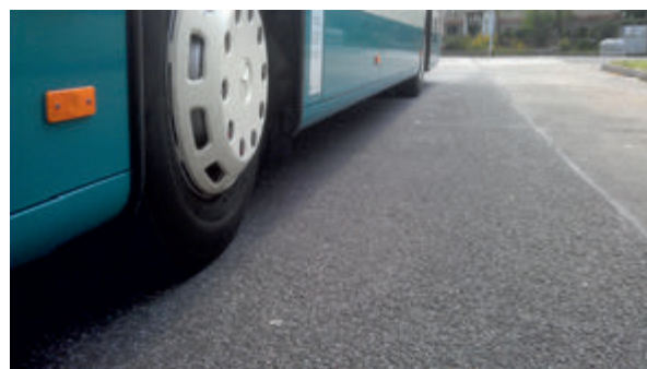
Abb. 2: Bushaltestelle in Gussasphalt im Zuge einer Betonstraße
